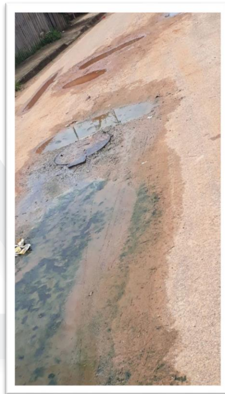
Figura 2 – Desobstrução de bueiro em via pública.
