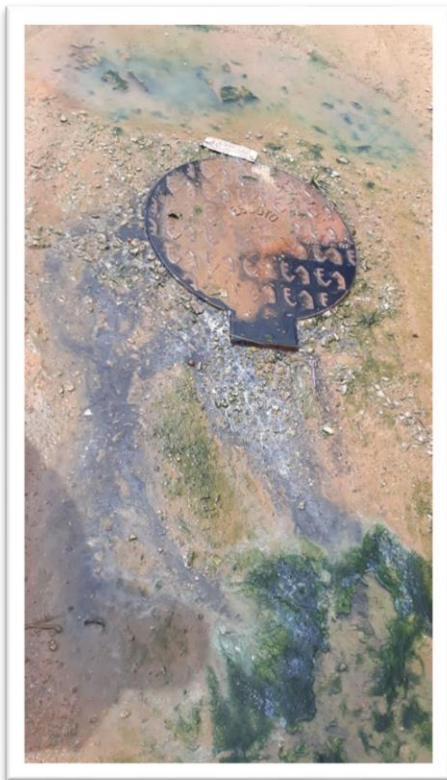
Figura 1 – Desobstrução de bueiro em via pública.
