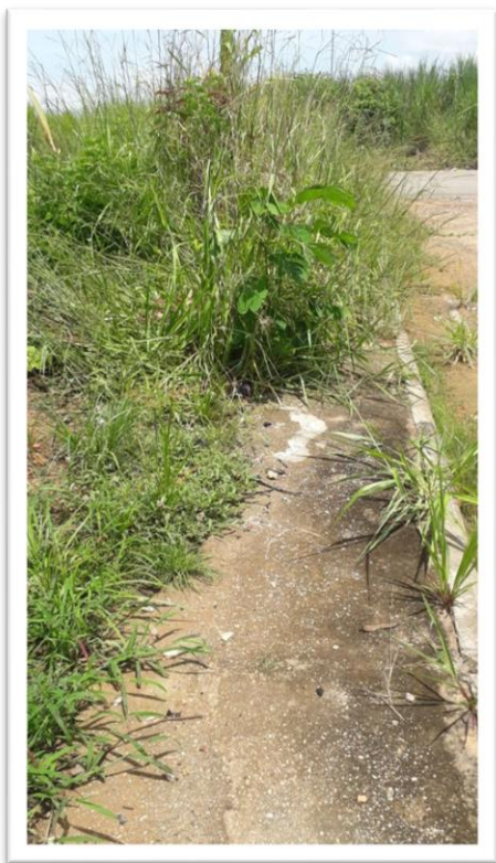
Figura 1 – Limpeza de calçadas em via pública.
