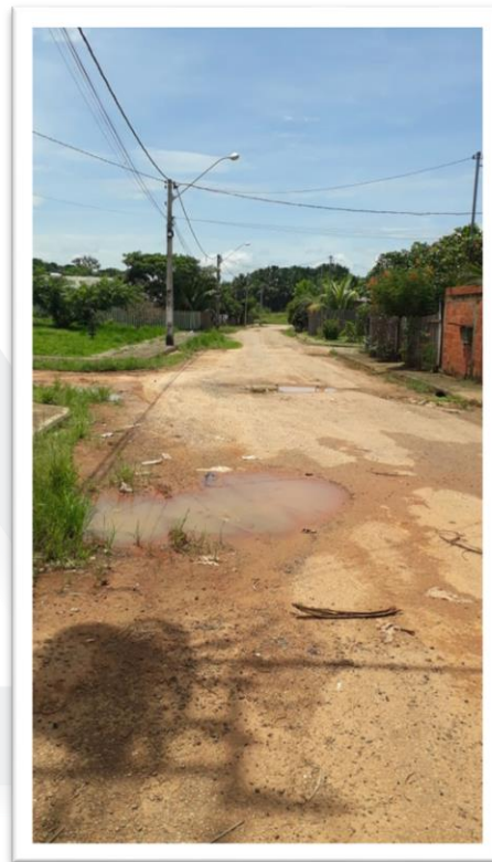
Figura 2 – Pavimentação de via pública.
