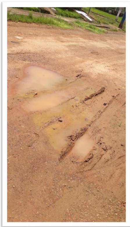
Figura 1 – Pavimentação de via pública.
