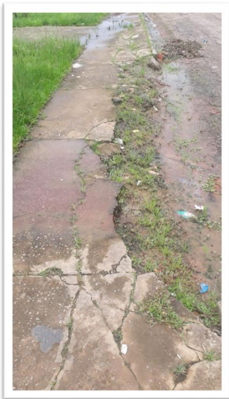
Figura 1 – Recuperação de Calçadas em Via Pública.
