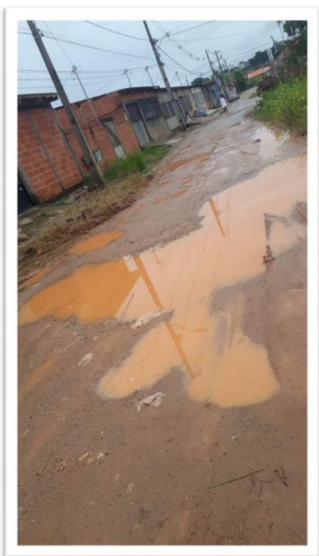
Figura 1 – Pavimentação de Via Pública.
