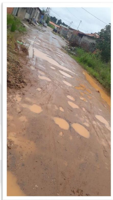
Figura 2 – Pavimentação de Via Pública.
