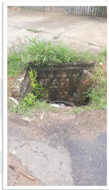
Figura 2 – Tapa de Bueiro em Via Pública.
