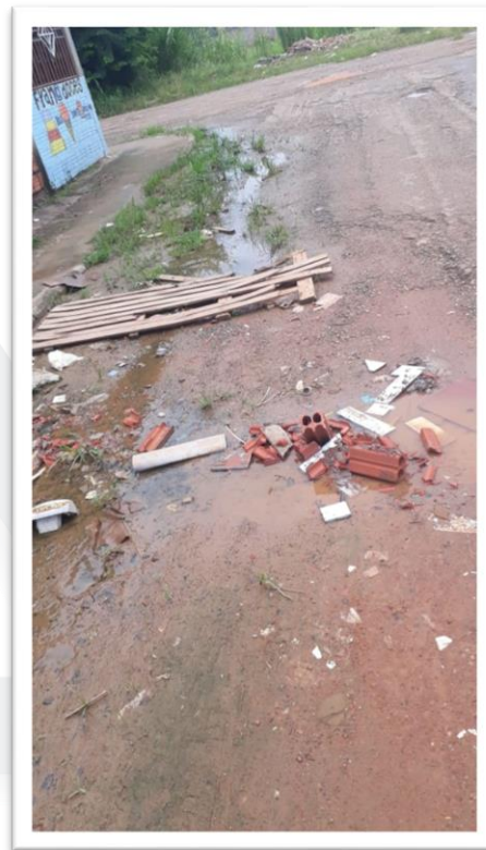
Figura 2 – Pavimentação de Via Pública.
