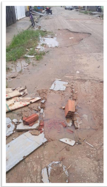
Figura 1 – Pavimentação de Via Pública.
