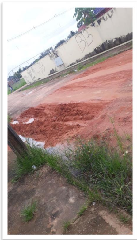
Figura 1 – Pavimentação de Via Pública.
