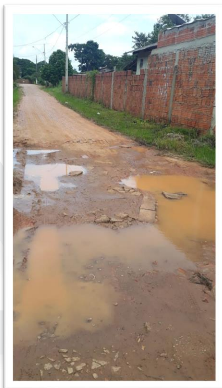
Figura 2 – Pavimentação de Via Pública.
