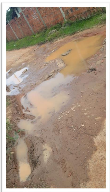
Figura 1 – Pavimentação de Via Pública.
