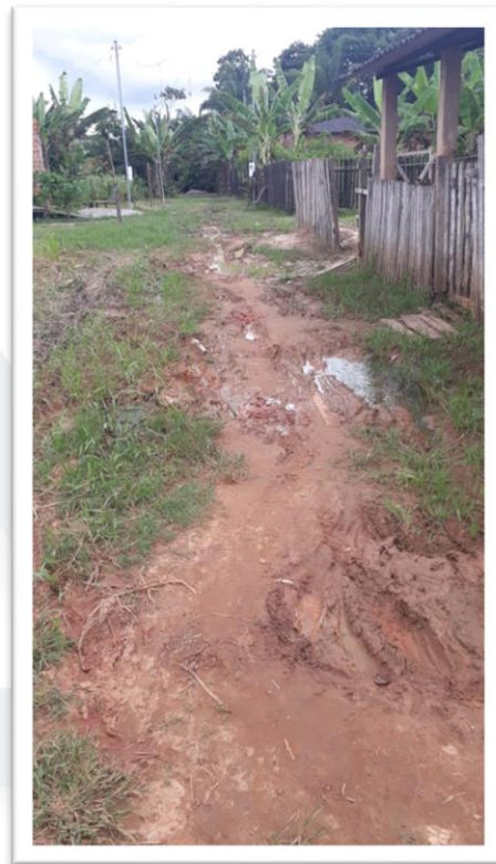
Figura 2–Pavimentação de Via Pública.
