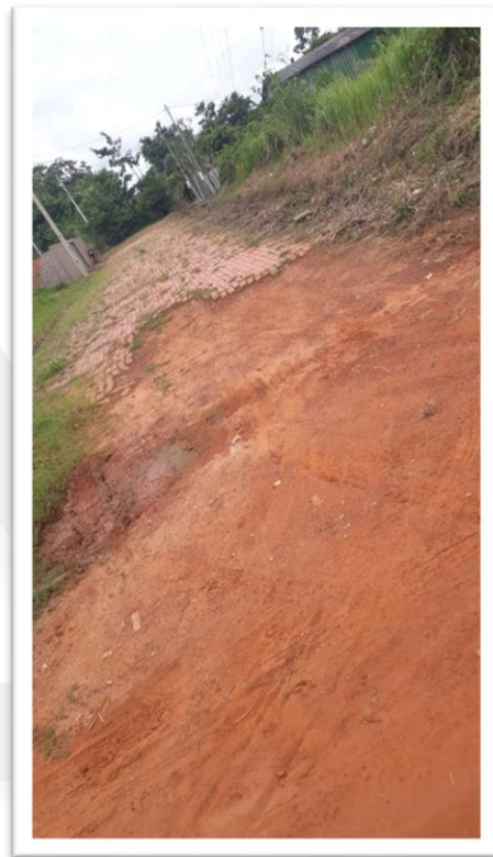
Figura 2–Pavimentação de Via Pública.
