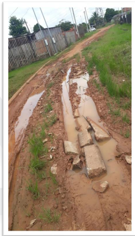
Figura 2 Pavimentação de Via Pública.
