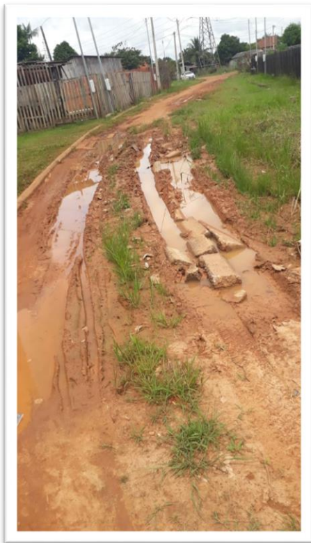
Figura 1 Pavimentação de Via Pública.
