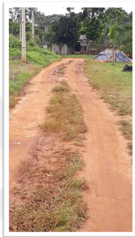
Figura 2--Pavimentação de Via Pública.
