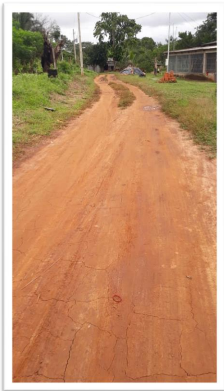
Figura 1-Pavimentação de Via Pública.
