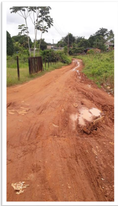
Figura 1-Pavimentação de Via Pública.
