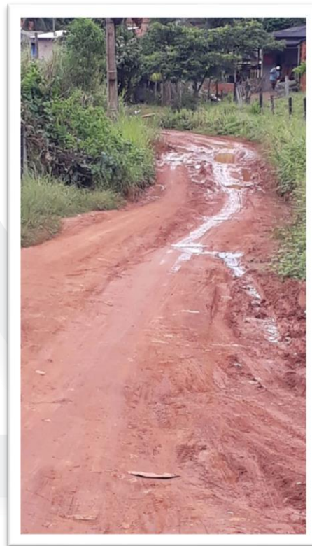
Figura 2--Pavimentação de Via Pública.
