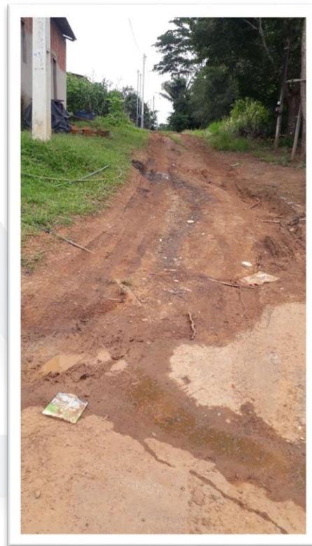
Figura 2--Pavimentação de Via Pública.
