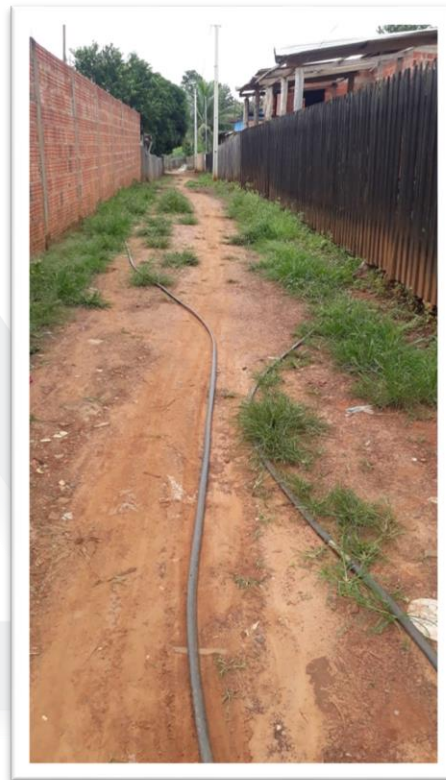
Figura 2--Pavimentação de Via Pública.
