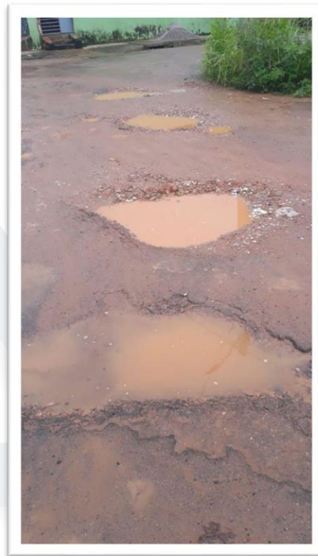
Figura 2 – Pavimentação de Via Pública.
