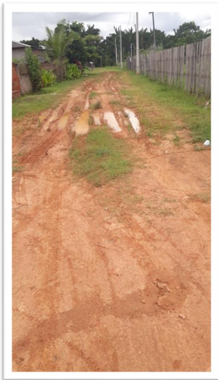
Figura 1-Pavimentação de Via Pública.
