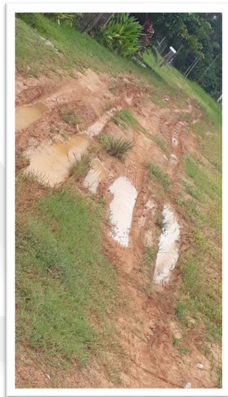
Figura 2--Pavimentação de Via Pública.
