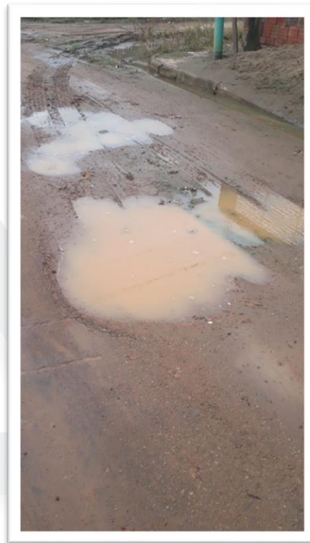
Figura 2 – Pavimentação de Via Pública.
