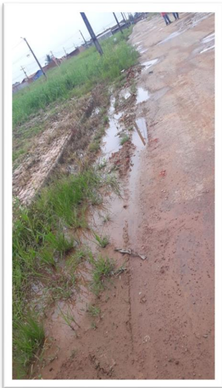
Figura 1 – Pavimentação de Via Pública.
