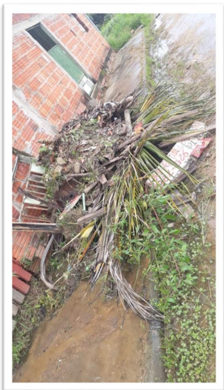
Figura 1 – Retirada de entulhos em via pública.
