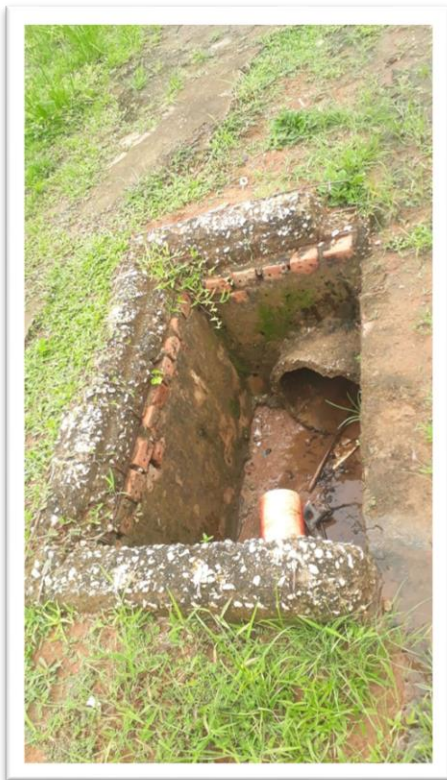
Figura 1 – Tampa de bueiro em via pública.
