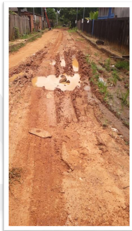
Figura 2-Pavimentação de Via Pública.
