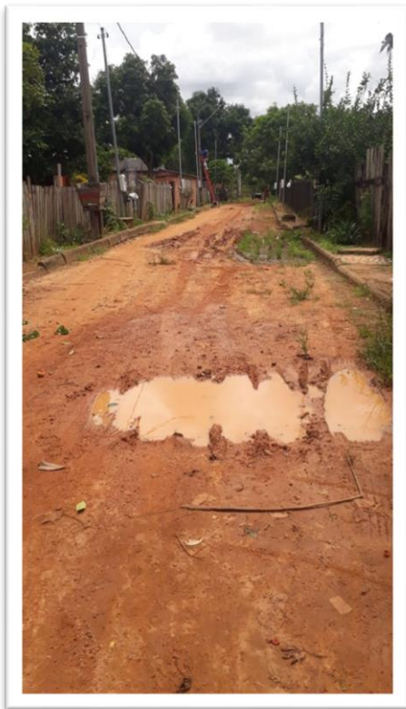
Figura 1-Pavimentação de Via Pública.
