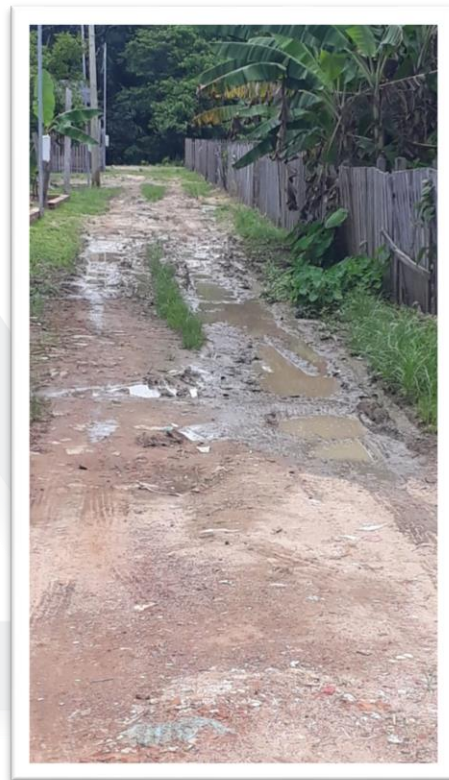
Figura 2--Pavimentação de Via Pública.
