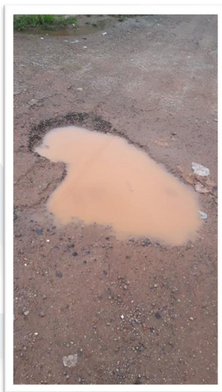
Figura 2 – Pavimentação de Via Pública.
