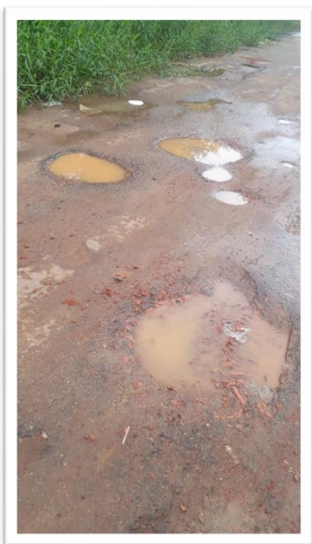
Figura 1 – Pavimentação de Via Pública.
