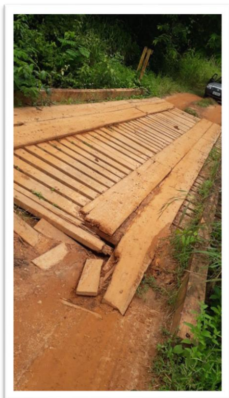
Figura 1-Reforma da Ponte sobre o Igarapé Liberdade no Ramal Clodoaldo Costa.
