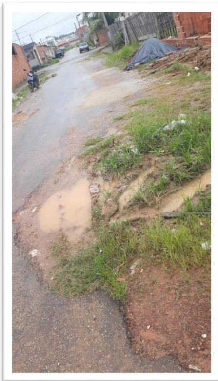
Figura 1 – Pavimentação de via pública.
