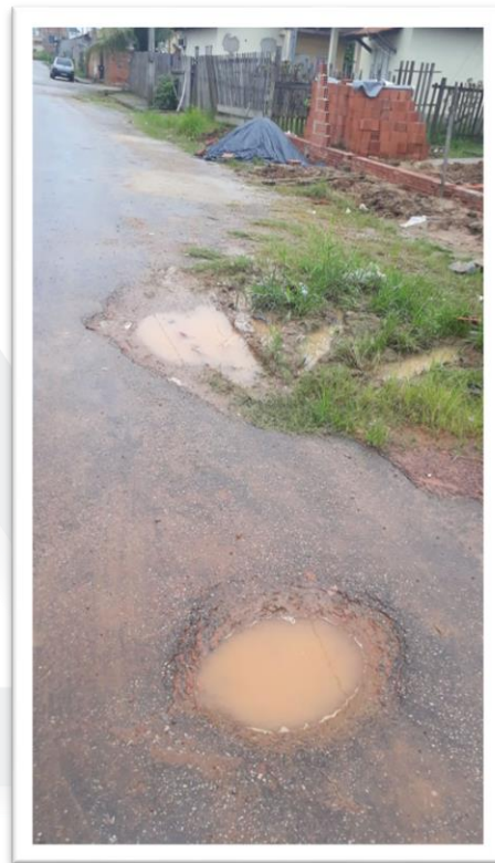
Figura 2 – Pavimentação de via pública.
