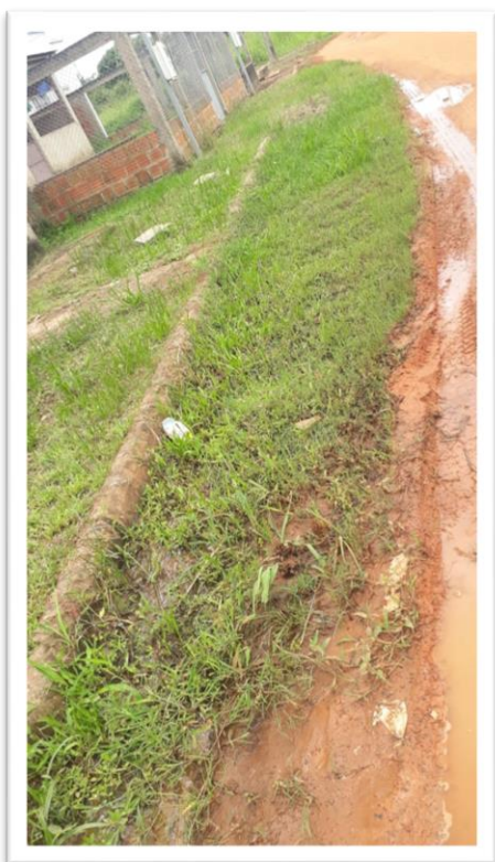
Figura 1-Limpeza de Via Pública.
