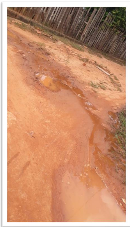
Figura 1-Pavimentação de Via Pública.
