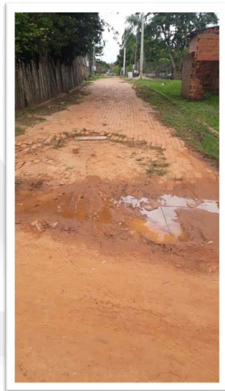
Figura 2-Pavimentação de Via Pública.
