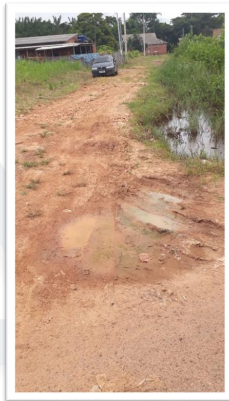
Figura 2--Pavimentação de Via Pública.
