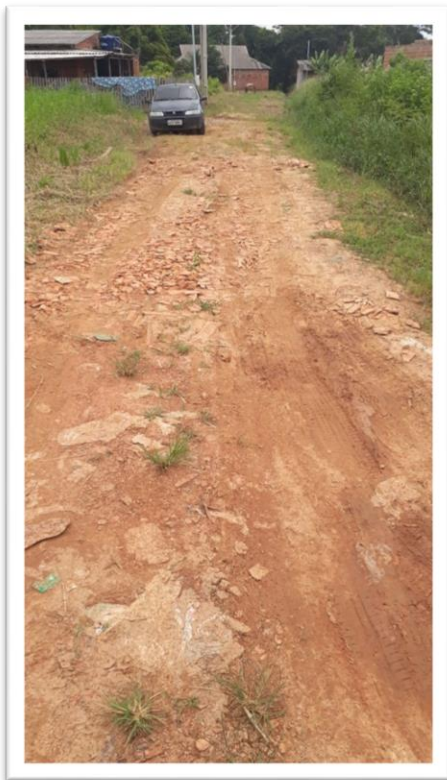
Figura 1-Pavimentação de Via Pública.
