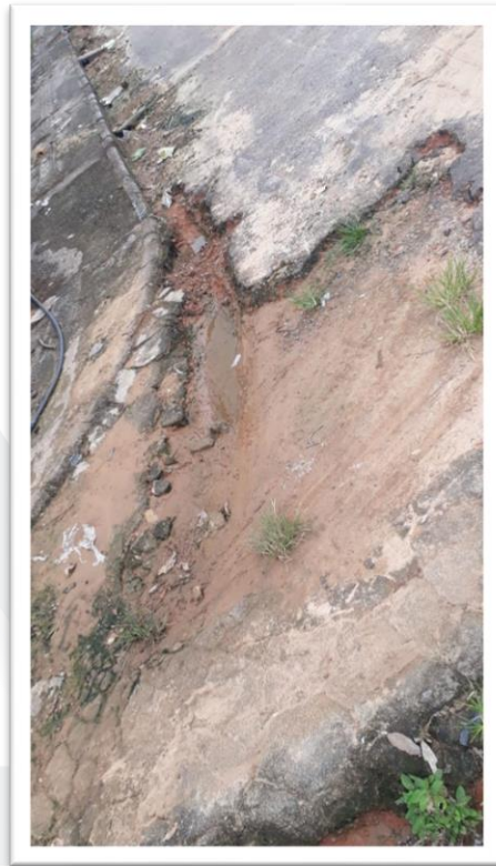
Figura 2-Pavimentação de Via Pública.
