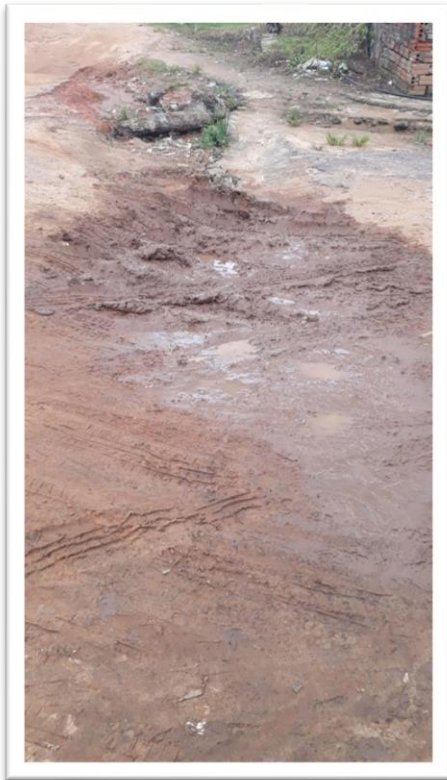
Figura 1-Pavimentação de Via Pública.
