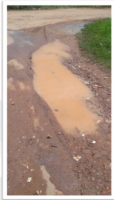
Figura 2-Pavimentação de Via Pública.
