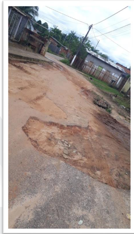
Figura 2-Pavimentação de Via Pública.
