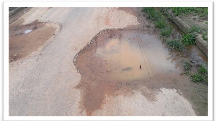
Figura 2-Pavimentação em Via Pública.
