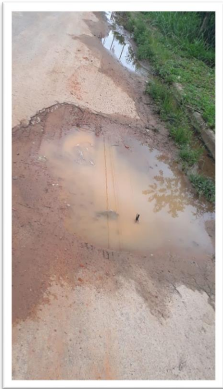
Figura 1-Pavimentação em Via Pública.
