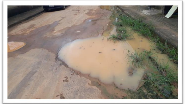
Figura 2-Pavimentação de Via Pública.
