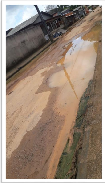
Figura 1-Pavimentação de Via Pública.
