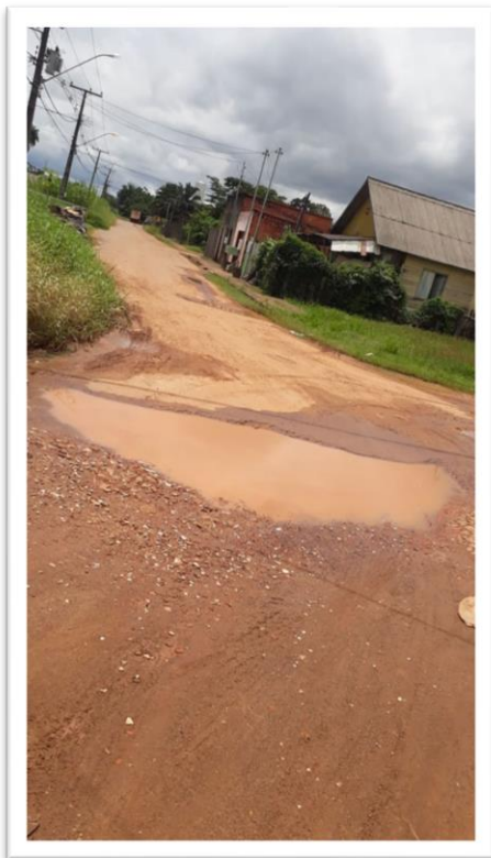
Figura 1-Pavimentação de Via Pública.
