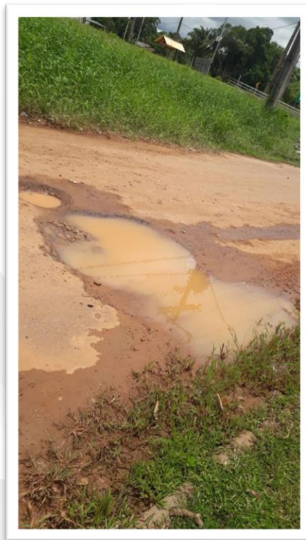
Figura 2-Pavimentação de Via Pública.
