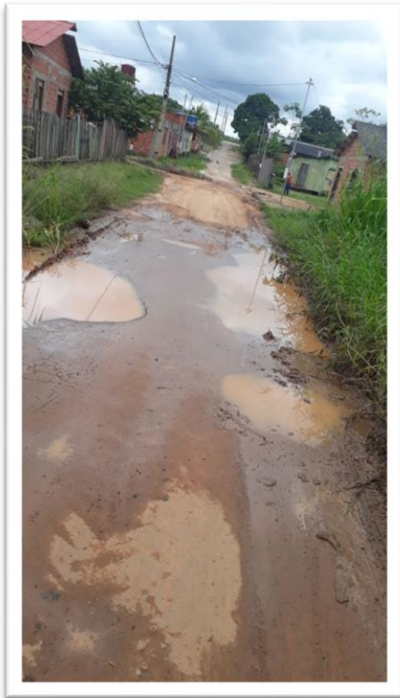
Figura 1-Pavimentação de Via Pública.
