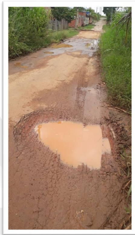
Figura 2-Pavimentação de Via Pública.
