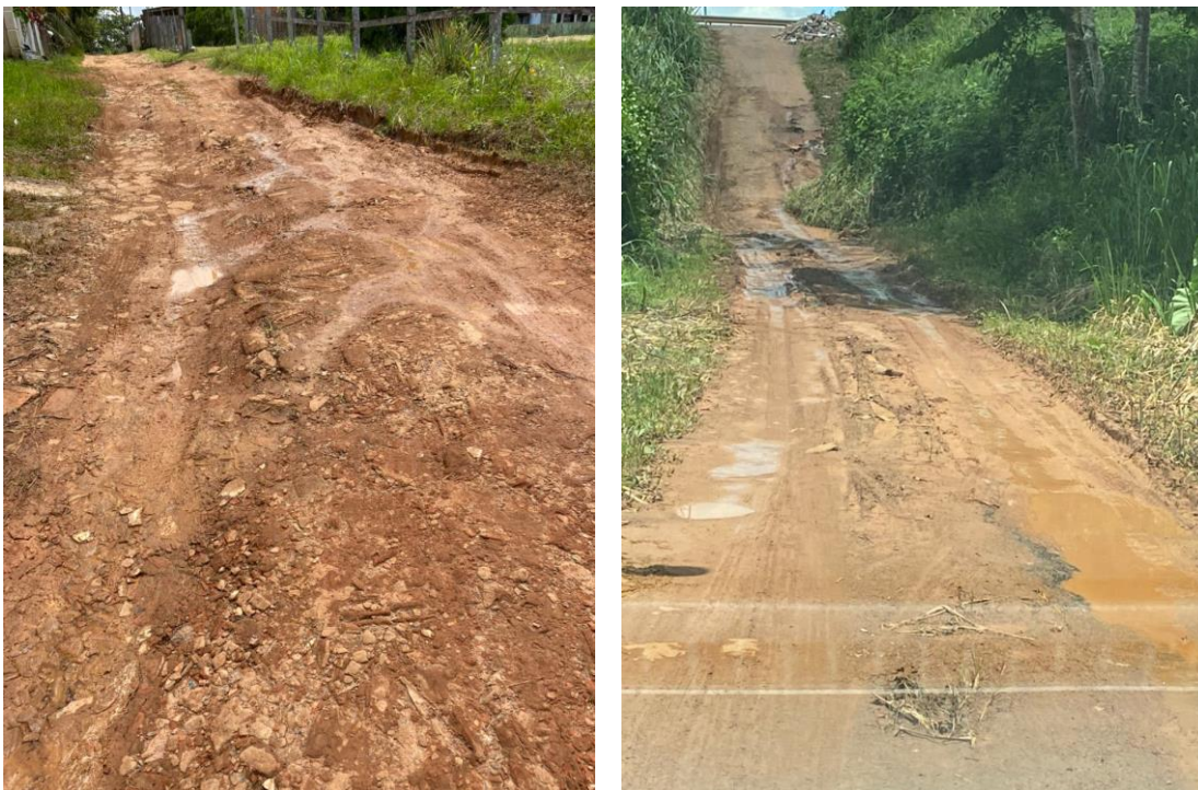
Figura 2 – Com as chuvas a Rua Independência fica muito perigosa com lama e buracos.
