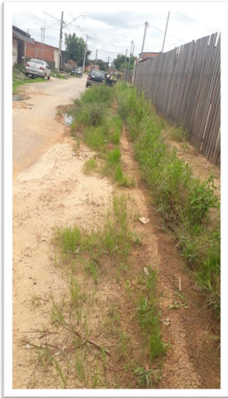
Figura 1- Limpeza de Via Pública.
