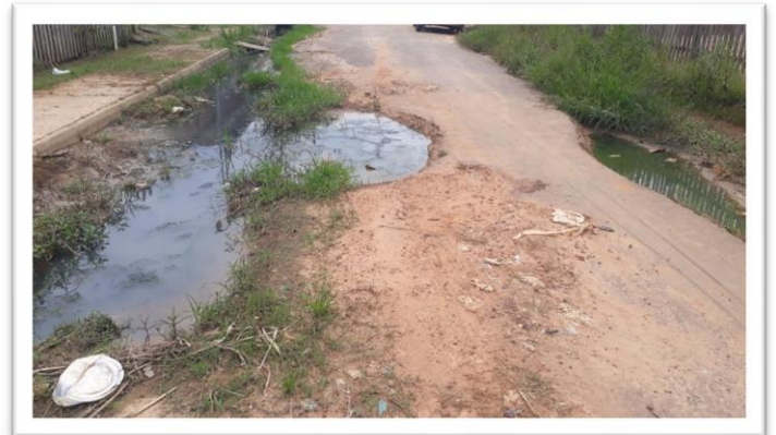
Figura 2- Pavimentação de Via Pública.
