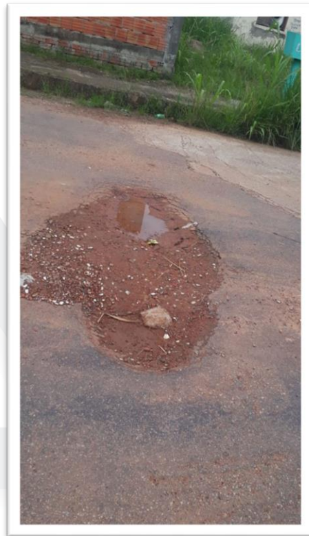
Figura 2- Pavimentação de Via Pública.
