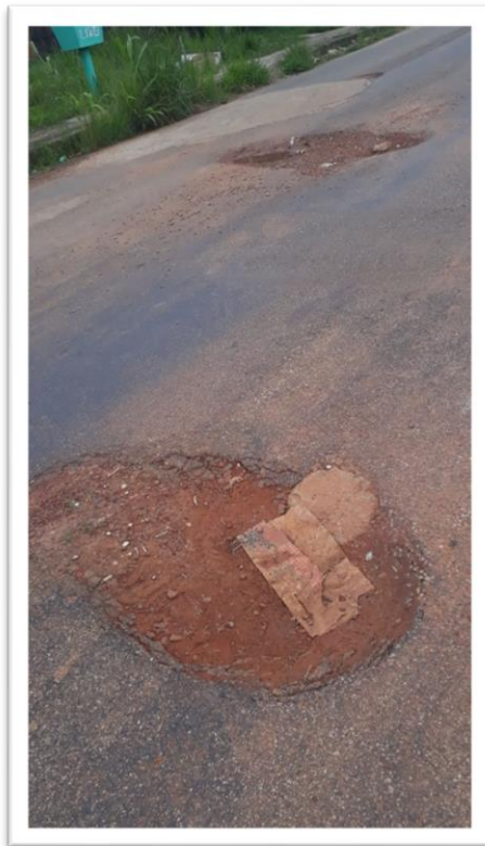
Figura 1- Pavimentação de Via Pública.
