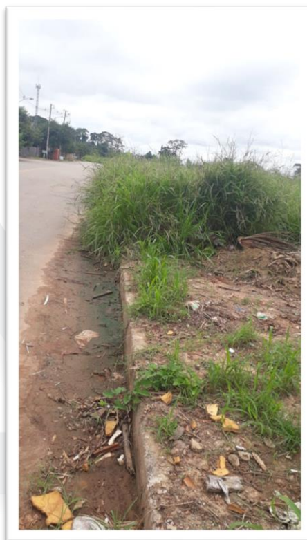
Figura 2- Limpeza da Calçada em Via Pública.
