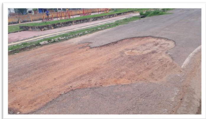
Figura 1- Pavimentação de Via Pública.
