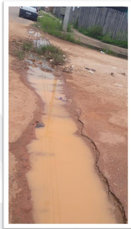
Figura 2- Pavimentação de Via Pública.
