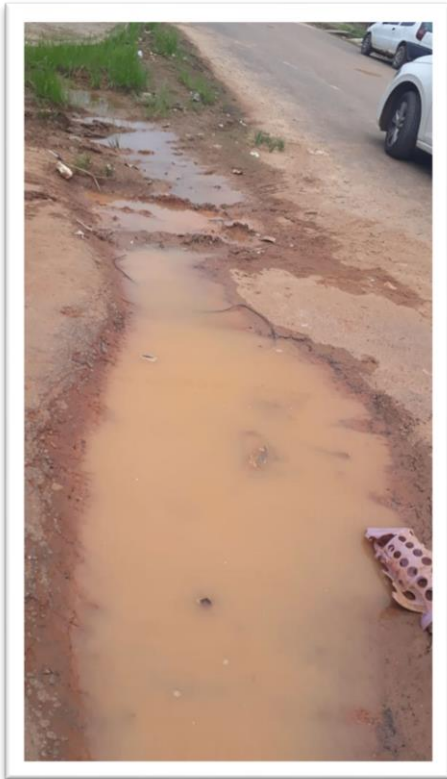
Figura 1- Pavimentação de Via Pública.
