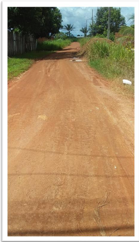
Figura 1-Pavimentação de Via Pública.
