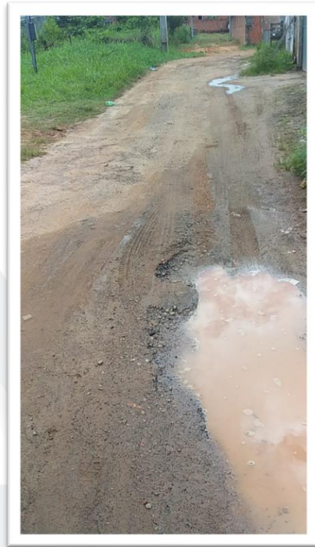
Figura 2-Pavimentação de Via Pública.
