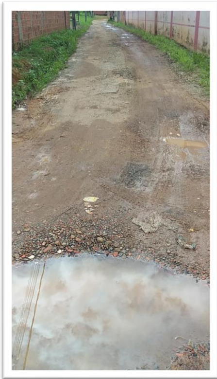
Figura 1-Pavimentação de Via Pública.
