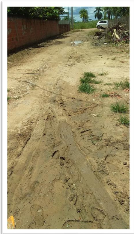
Figura 1-Pavimentação de Via Pública.
