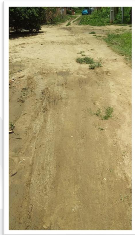
Figura 2-Pavimentação de Via Pública.
