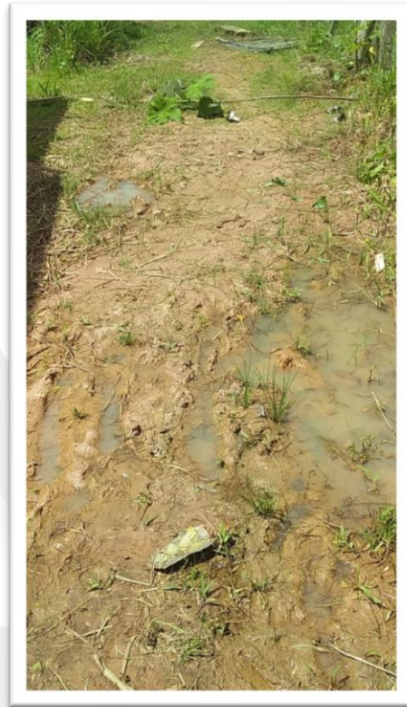
Figura 2-Pavimentação de Via Pública.
