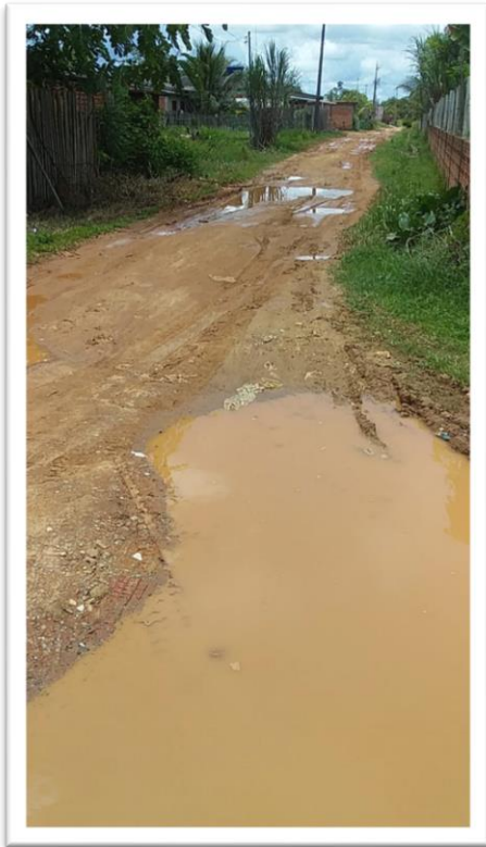
Figura 1-Pavimentação de Via Pública.
