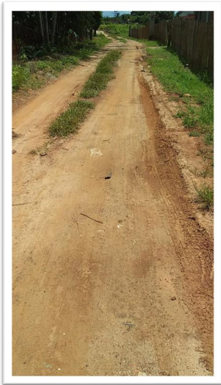
Figura 1-Pavimentação de Via Pública.
