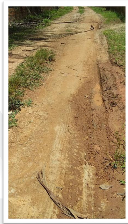
Figura 2-Pavimentação de Via Pública.
