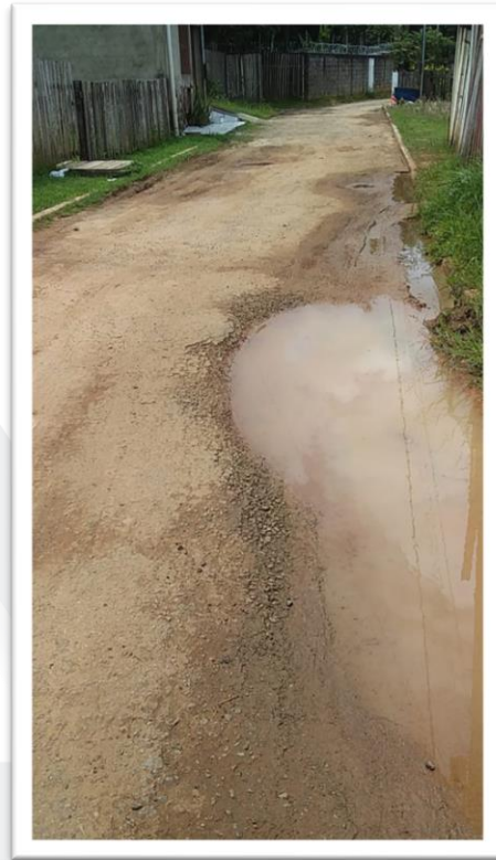
Figura 2-Pavimentação de Via Pública.
