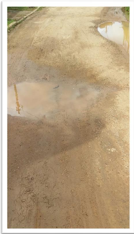
Figura 1-Pavimentação de Via Pública.
